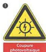
Ce groupe d'étiquettes signale l'AGCP de production qui va isoler l'installation PV coté a.c. du réseau de distribution.
